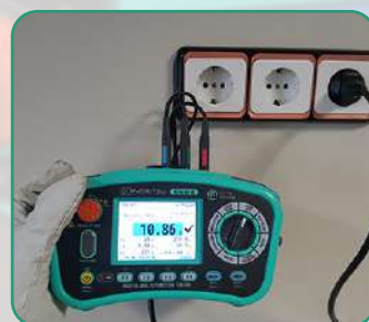
Pomiar impedancji pętli
