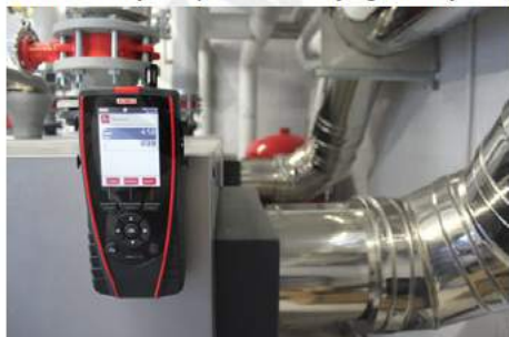
Pomiar warunków klimatycznych
